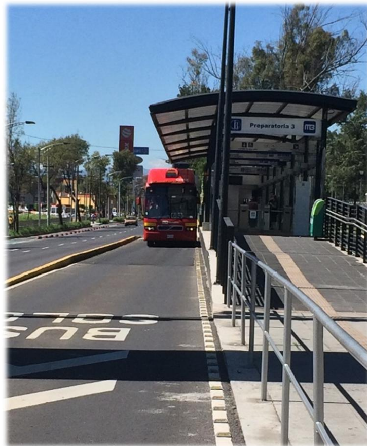
Estación del Metrobús
