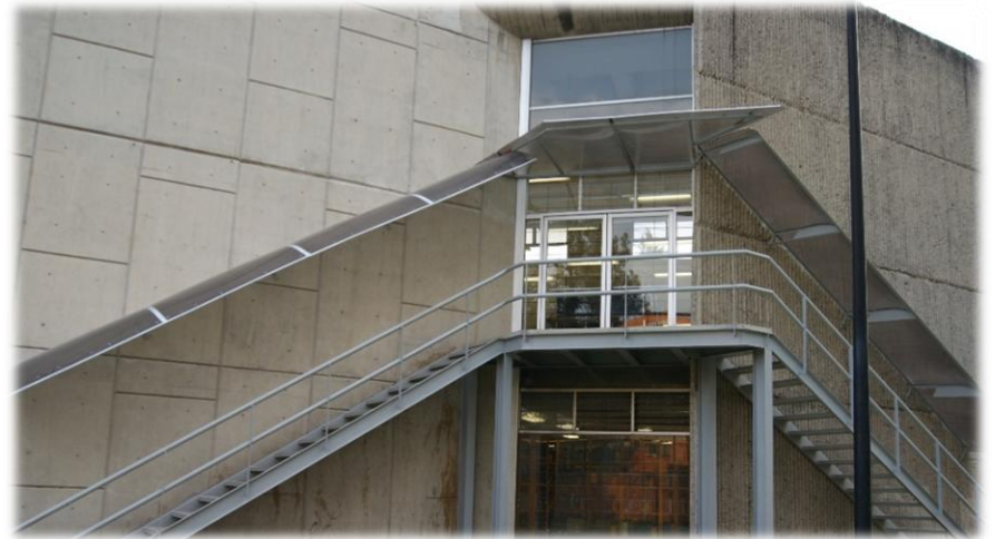
Escaleras de emergencia
