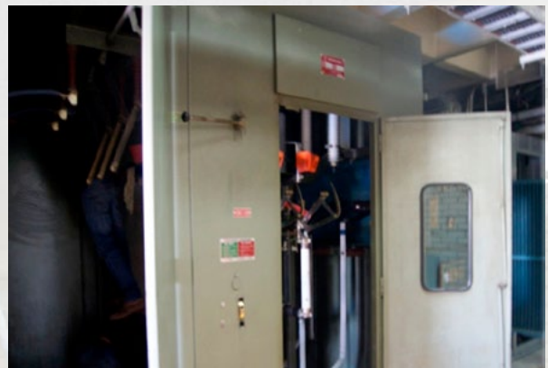
Mantenimiento a las subestaciones eléctricas
