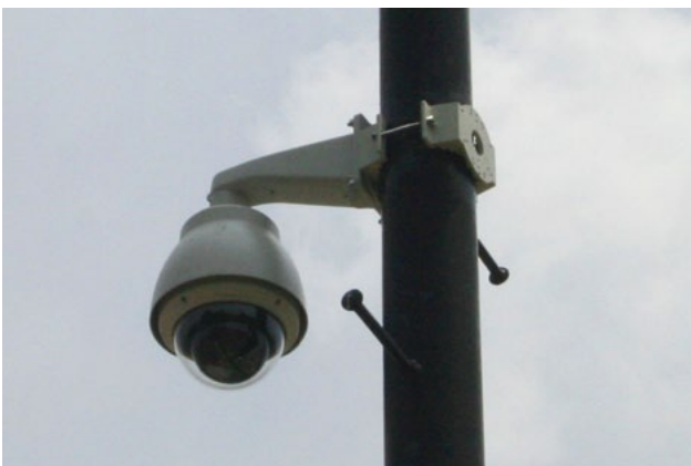
Colocación de cámaras de seguridad
