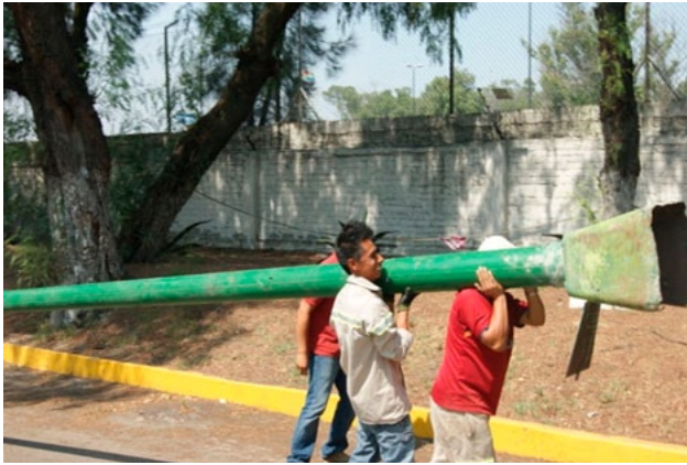
Colocación de luminarias de alumbrado público en la barda colindante con el jardín de Cinemex (Con apoyo de la Delegación Gustavo A. Madero)
