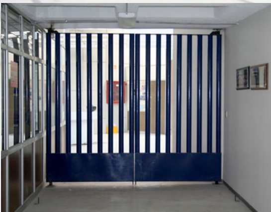
Habilitación de equipo y colocación de reja
