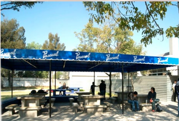
Construcción de mesetas de concreto en el área de Cafetería de Alumnos
