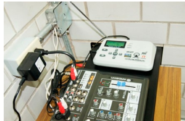
Colocación de alarma sísmica
