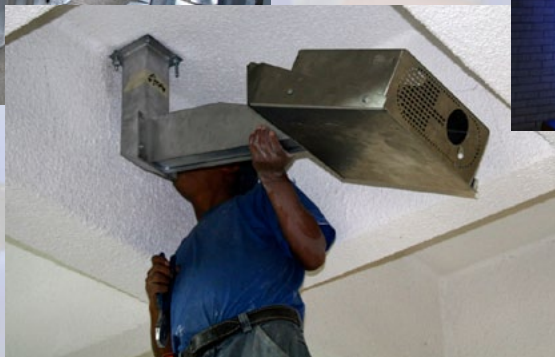
Colocacion de bichos, videoproyectores y cajas tipo nema en diferentes aulas
