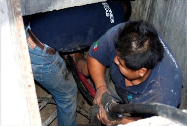
Sustitución de acometida a subestación transmisora
