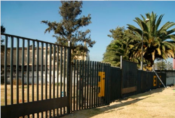
Colocación de reja en las áreas verdes
