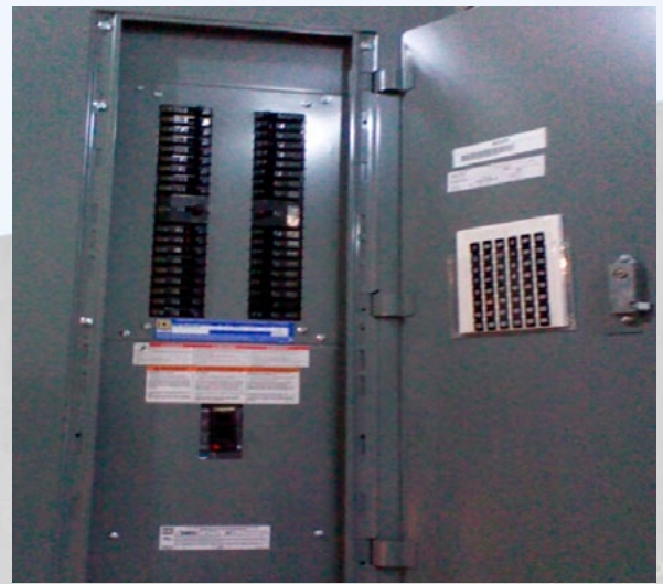
Sustitución del tablero de distribución
