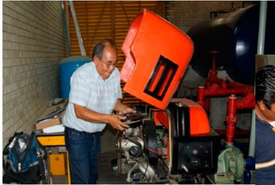
Mantenimiento a equipos hidroneumáticos
