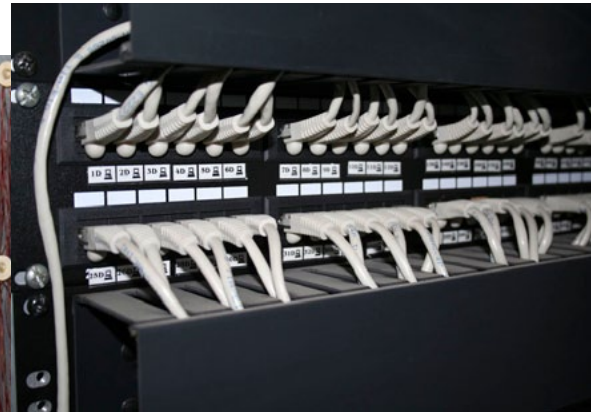
Instalación de red en los Centros de Cómputo
