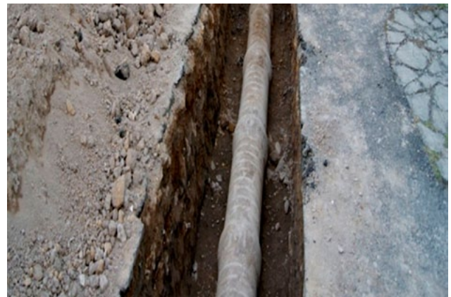
Renivelación del drenaje desde el Edificio B al estacionamiento de Funcionarios
