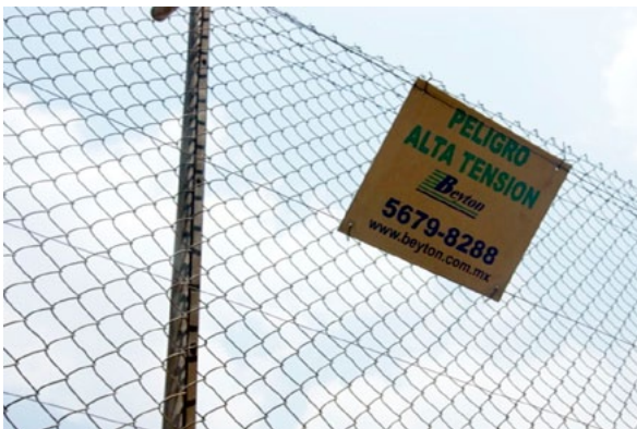
Colocación de malla electrificada en barda perimetral
