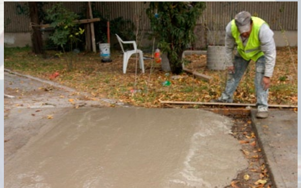
Renivelación de banquetas en mal estado y sustitución de tapas de coladeras en todo el Plantel
