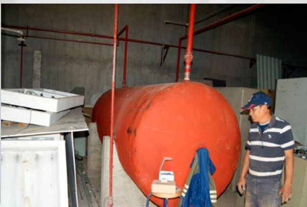
Sustitución del tanque de almacenamiento de agua caliente de las calderas
