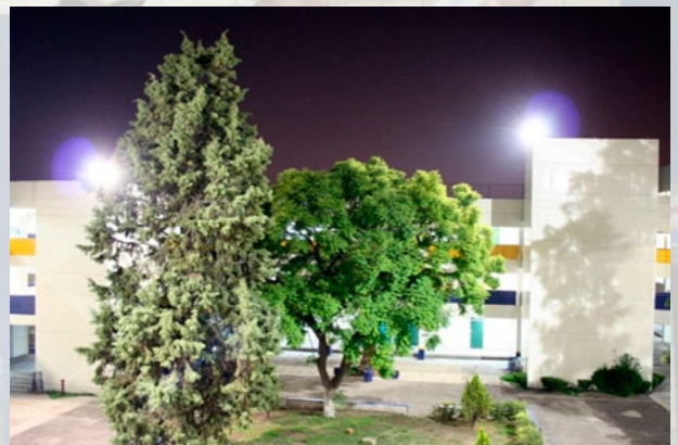
Colocación de luminarias y mantenimiento correctivo al alumbrado exterior
