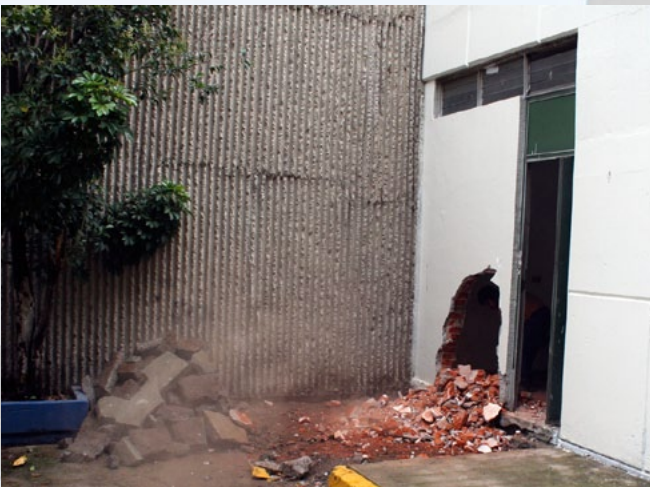
Ampliación y colocación del portón en acceso a camerinos
