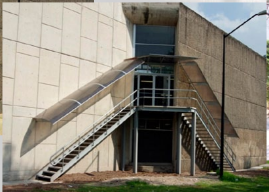
Construcción de escalera de emergencia en el primer nivel
