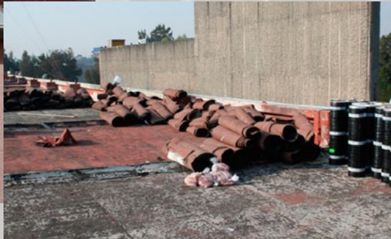
Impermeabilización de Azoteas Edificios "C" y "D"
