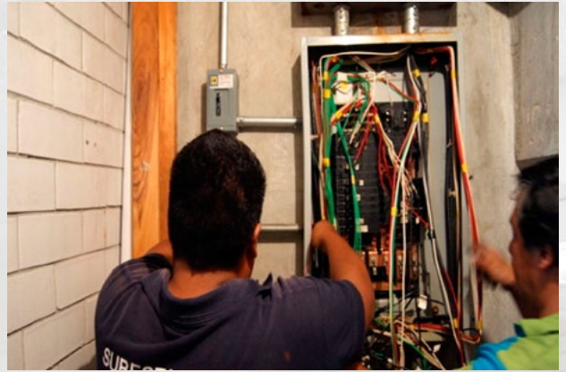
Sustitución de tableros de distribución en el Gimnasio y del Edificio "A"
