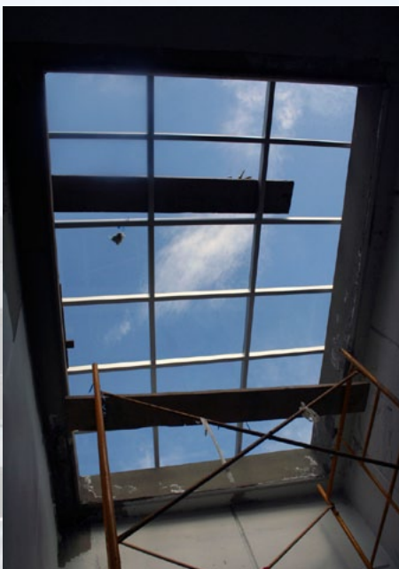
Sustitución del domo
