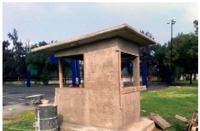
Construcción de caseta de apoyo a emergencias en Áreas Verdes
