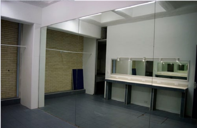
Remodelación de camerinos
