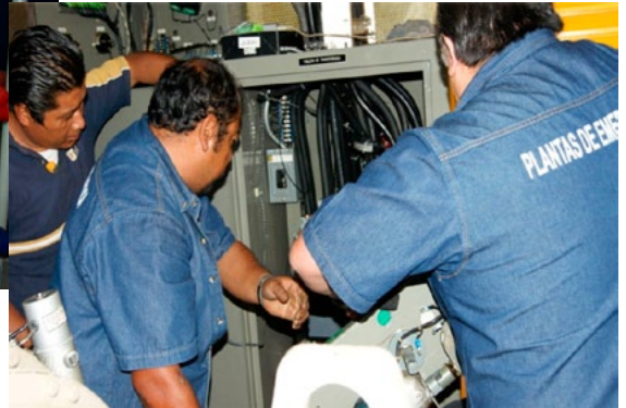
Mantenimiento a planta de emergencia
