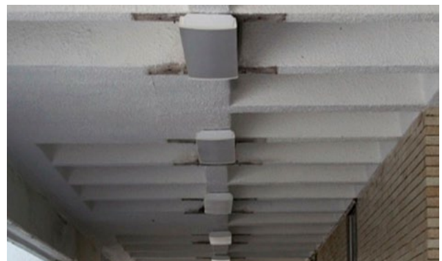
Sustitución de luminarias de los pasillos y vestíbulo
