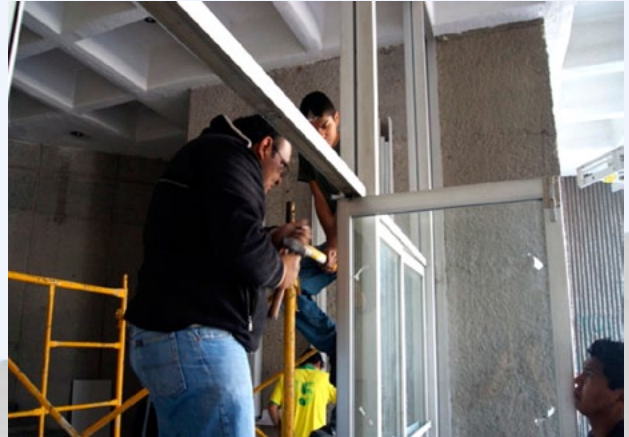
Reubicación de la cancelería del acceso principal
