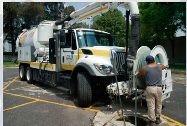
Desazolve a la red general de drenaje y alcantarillado (apoyo de la Delegación Gustavo A. Madero)
