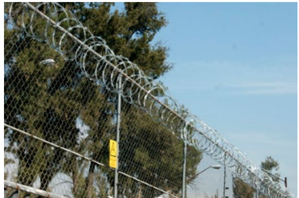
Colocación de concertina
