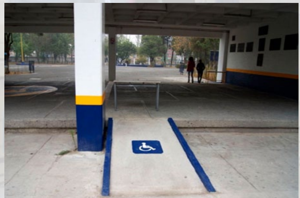
Construcción de rampas para discapacitados en diversas áreas
