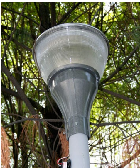
Colocación de faroles en andadores del plantel
