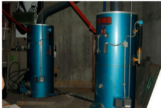
Mantenimiento a calderas del Plantel
