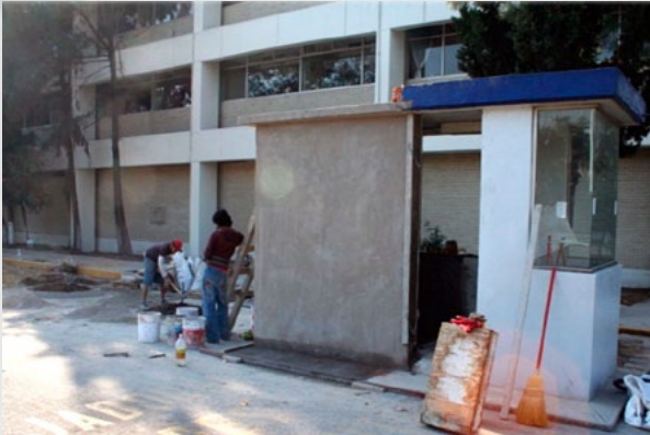
Ampliación de la caseta en el estacionamiento para Académicos del Plantel
