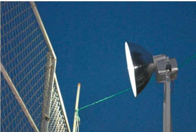
Colocación de luminarias en el acceso al Plantel
