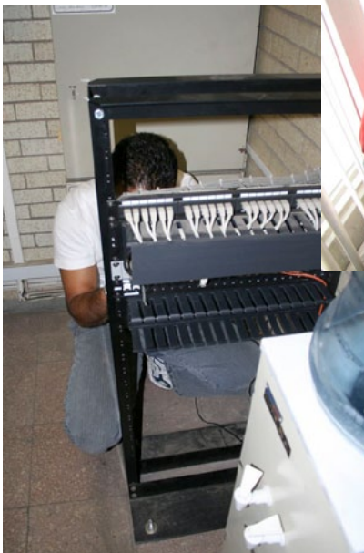
Instalación de red en el CRED
